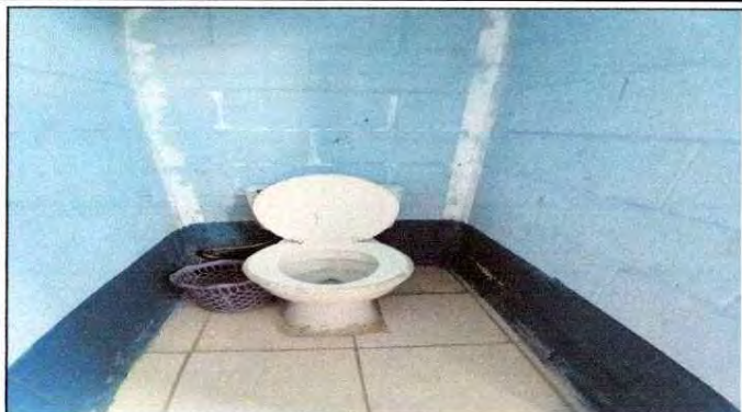
Foto 7: Sustrucción de inodoro
