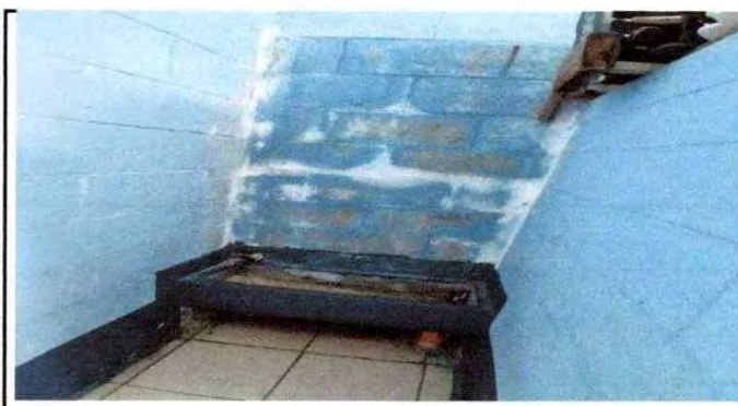
Foto 10: Sustrucción de azulejo
