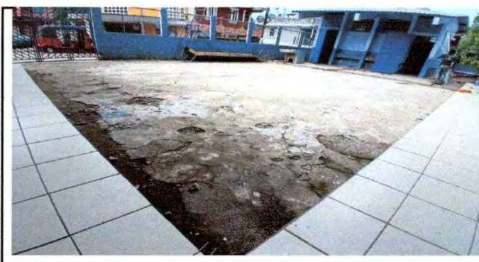
Foto 12: Reparación de plancha de concreto de patio
