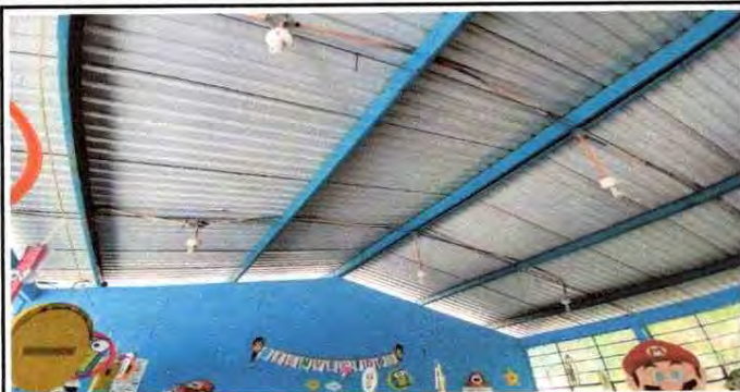
Foto 13: Sustitución de lámparas tipo led
