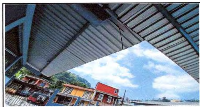
Foto 5: Sustitución de canal de metal
