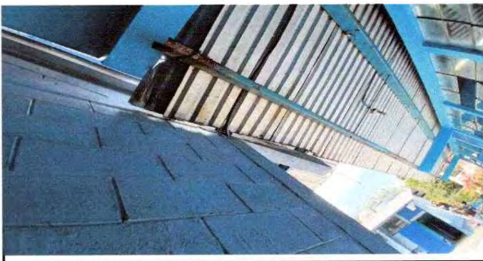
Foto 6: Sustitución de canal de metal
