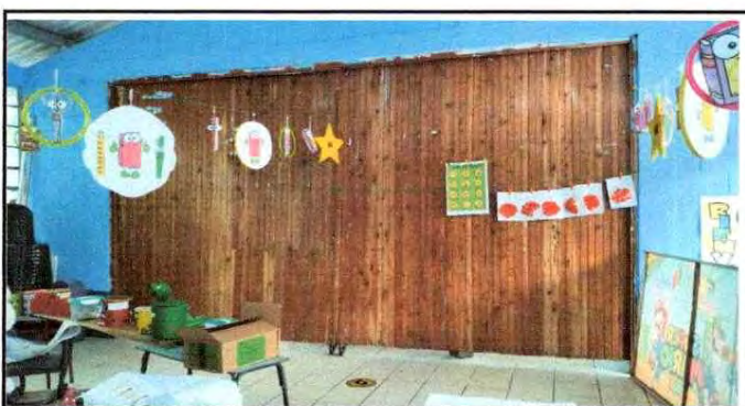
Foto 11: Sustrucción de entrepaño por muro de block y cerramiento
