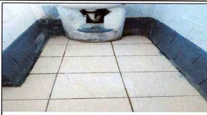
Foto 8: Sustrucción de lavamanos
