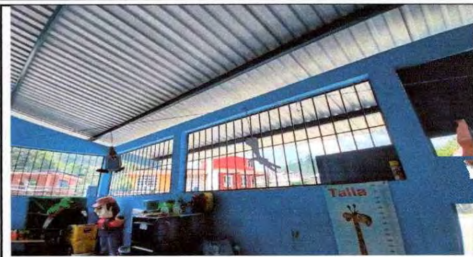
Foto 2: Sustitución de ventanas de metal por pvc con mosquitero
