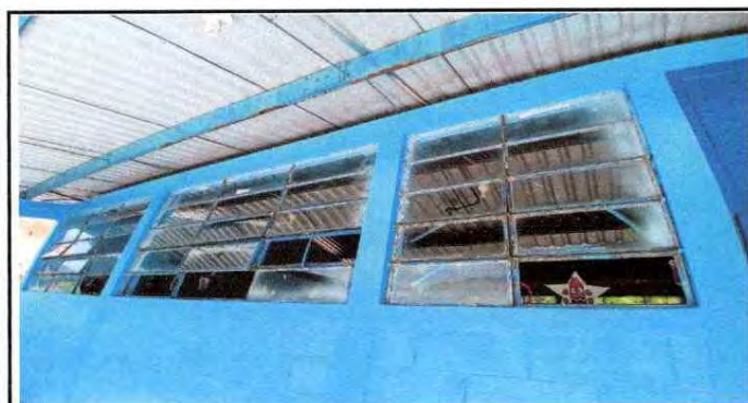
Foto 3: Sustitución de ventanas de metal por pvc con mosquitero
